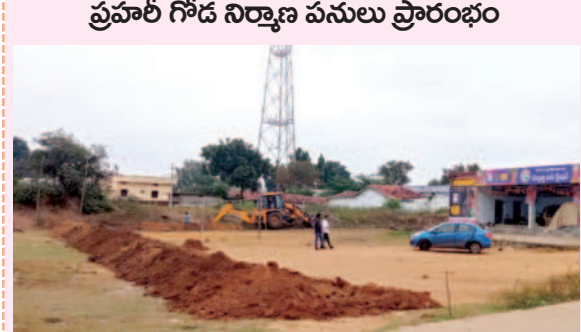
ప్రహరీ గోడ నిర్మాణ వసూలు కొనసాగుతున్న దృక్పథం
